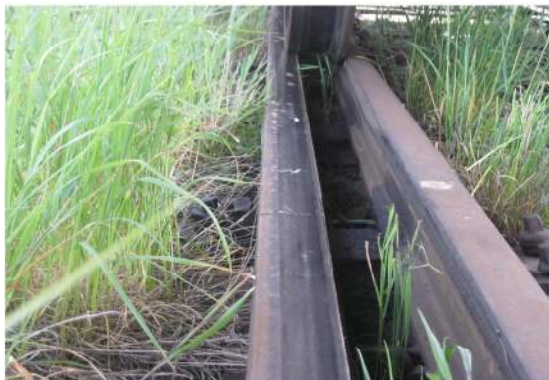
foto nr. 2 - urma de rulare și cădere a roții din partea dreaptă
