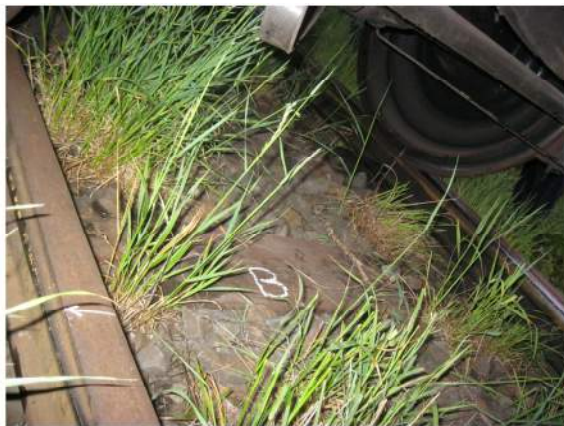
foto nr. 10 – traversa „B”
