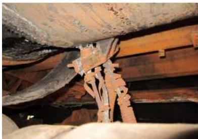
Foto- izolația cablurilor la ieșirea din motorul electric, arsă
