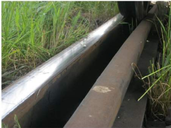
foto nr. 1 - urma de rulare și cădere a roții din partea dreaptă
