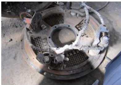
Foto – suport portperie cu legătura flexibilă a periei colectoare secționată și urme de topitură
