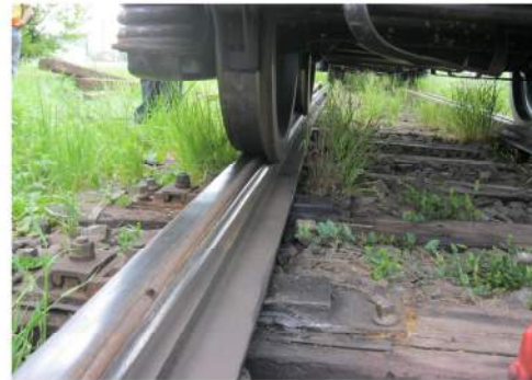
foto nr. 11 – boghiul nr. 2 al vagonului aflat pe locul cu primele urme de deraiere – partea stângă
