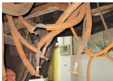
Foto - izolația cablurilor aferente motorului electric arsă, iar placa de borne lipsă în urma arderii
