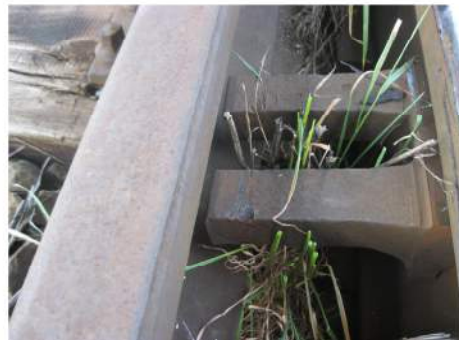
foto nr. 4 – urme de lovire pe proțap ale bandajului (buză și față activă)
