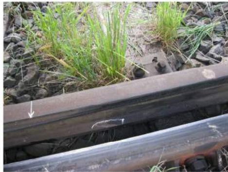
foto nr. 3 – urmele de frecare datorate căderii roții din dreapta pe suprafața de rulare și de lovire a tălpii acului
