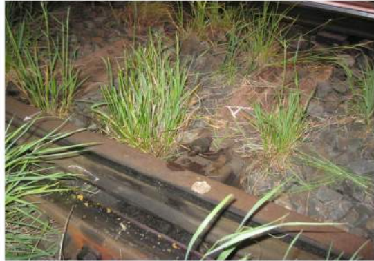
foto nr. 9 – traversa „A” cu cele două tirfoane cu ruptură veche 100 %
